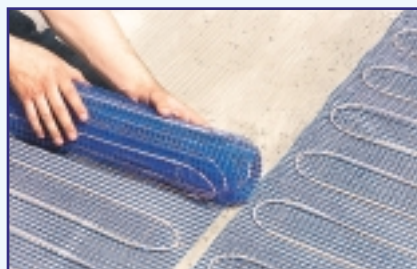
Mata grzejna ELEKTRA wykonana zgodnie z PN-IEC 1423-1, PN-IEC 1423-2 i BBJ-98 KT-1001
